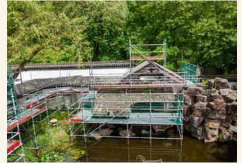
Sanierung des Chinesischen Gartens
