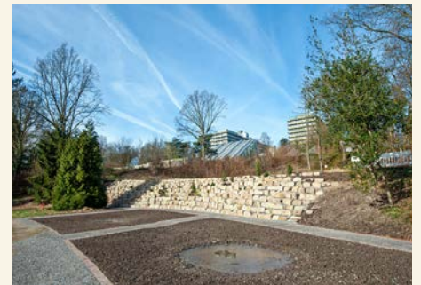
Hier entsteht eine natürliche Feuchtwiese
